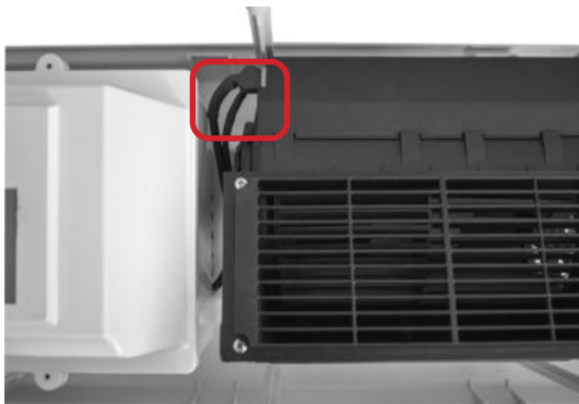
Abb. 7.4.2.6: Gebläsestecker anschließen
